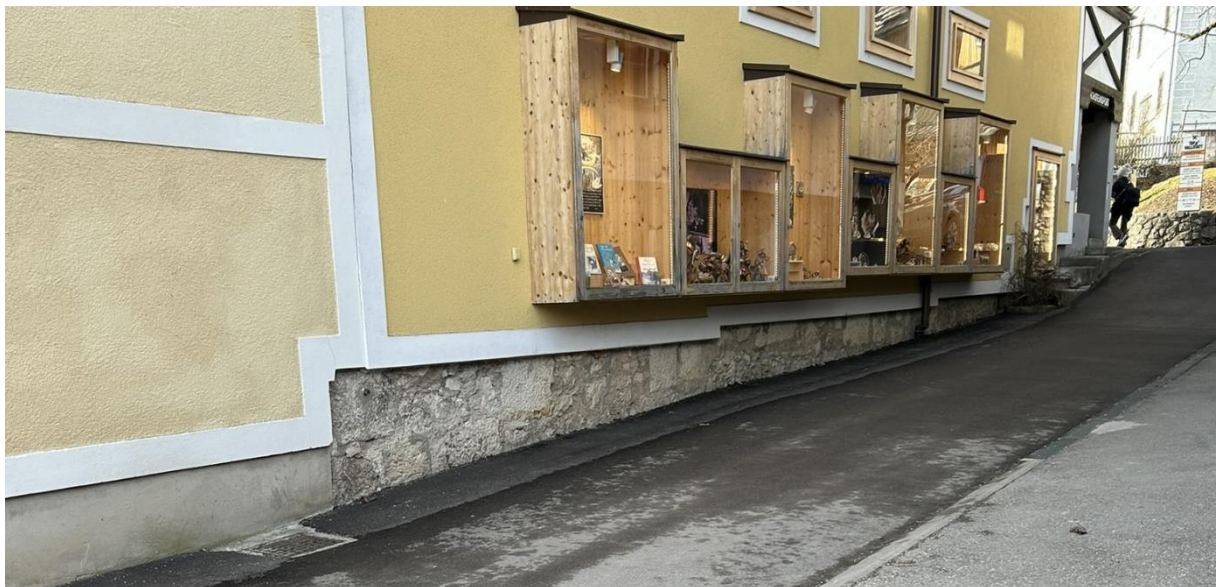
Abbildung 17 Fundament Nordost des Hauses Seestraße 50, Foto F. Idam
