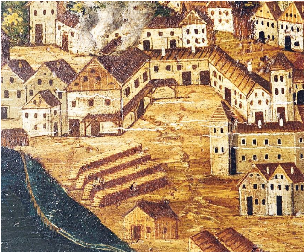
Abbildung 9: Pfannhaus mit durch das Dach abziehenden Rauch und Brüden (Wasserdampf), vor 1750 – Anonym, Museum Hallstatt Inventar Nr. 513.
